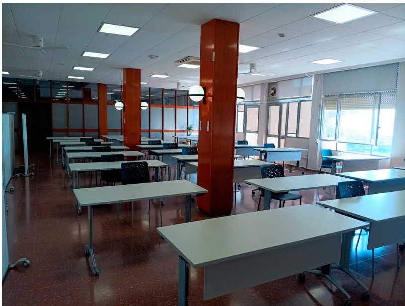
Obres d'interconnexió entre ambdós edificis i condicionament de diferents espais (2024).
