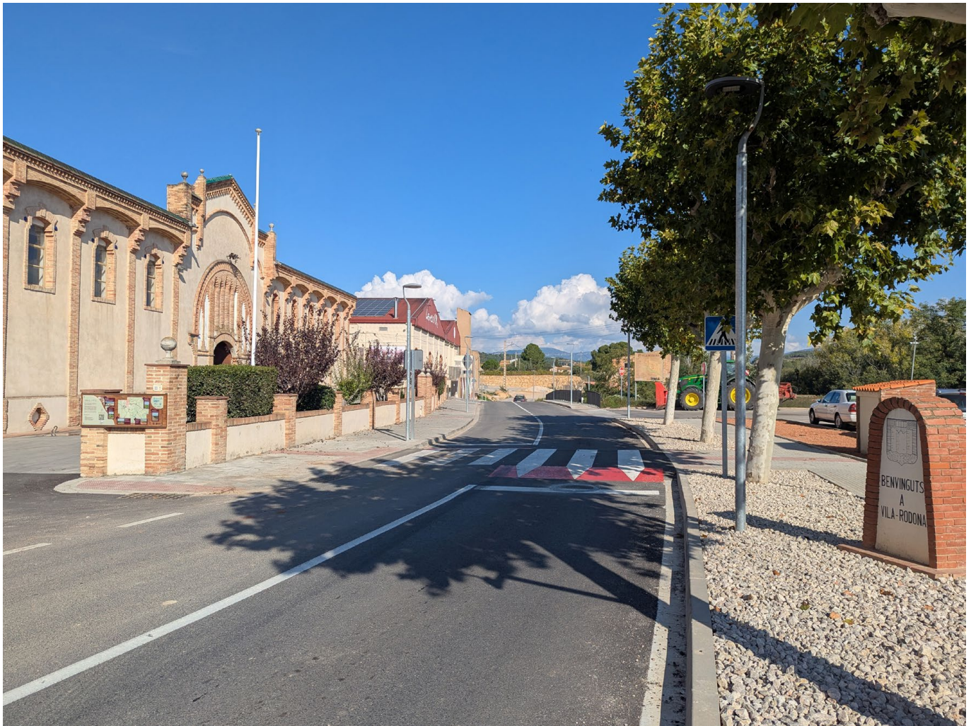
Condicionament de les travesseres de Vila-rodon, carreteres TP-2003 i TV-2443.
