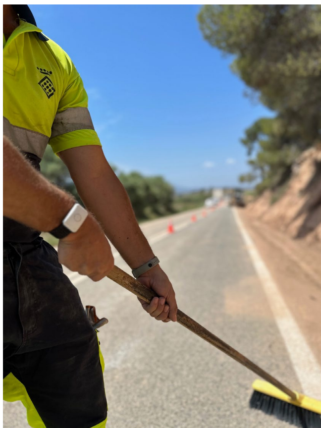
Polsera per prevenir els efectes del calor en la realització de treballs a l'exterior.
