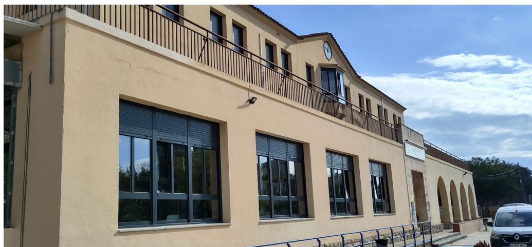
Substitució de la fusteria exterior de l'edifici central del CEE Sant Rafael.
