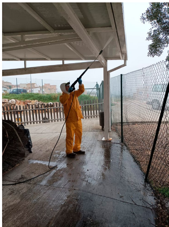
Neteja i pintura a la zona de les piscines, Freginals
