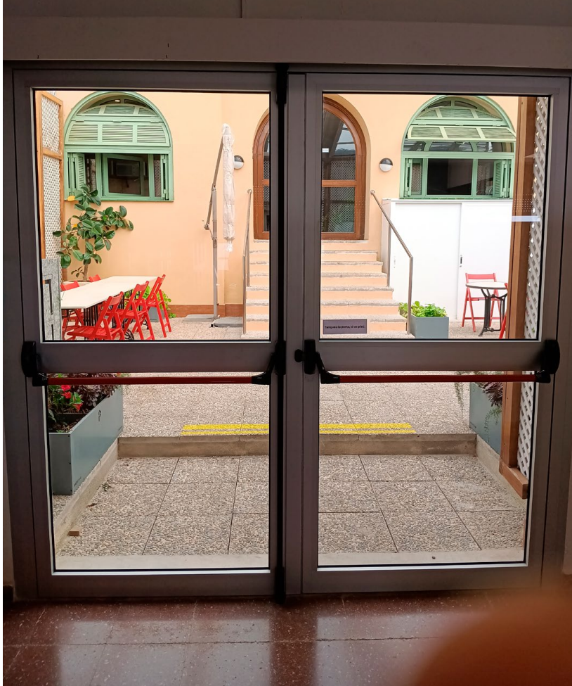
Obres d'interconnexió entre ambdós edificis i condicionament de diferents espais (2024)
