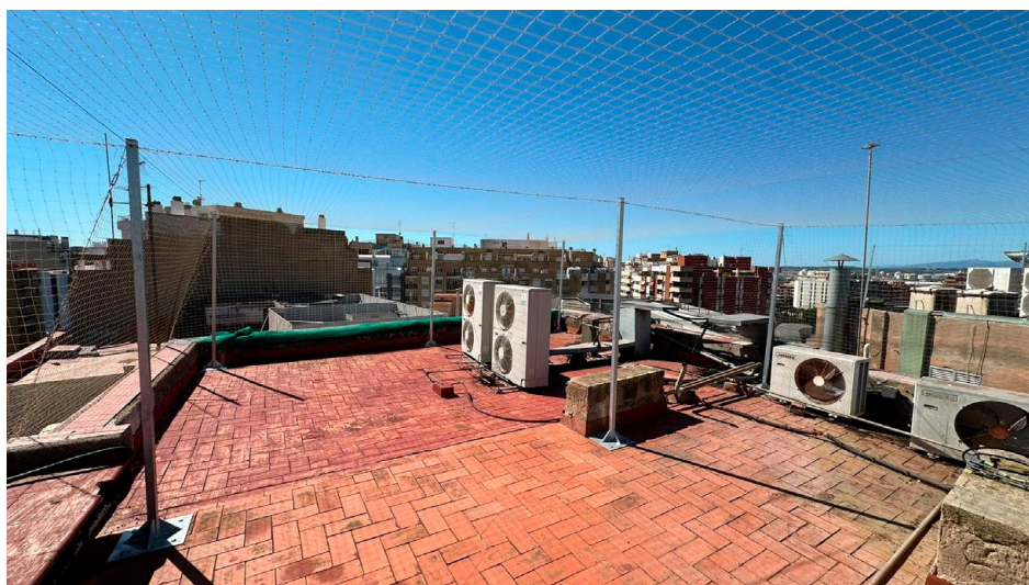
Actuacions de condicionament i manteniment de l'edifici del 2024.
