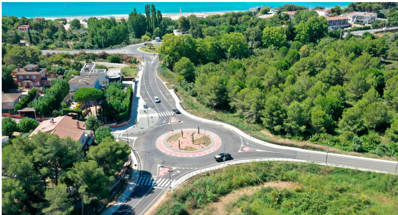
Condicionament de la carretera TP-2039 del Catllar a l'N-340. Tram T-203 a N-340.
