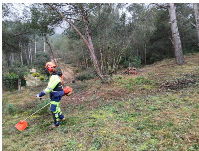
Treballs de neteja del terreny a Les Voltes, Riudecols
