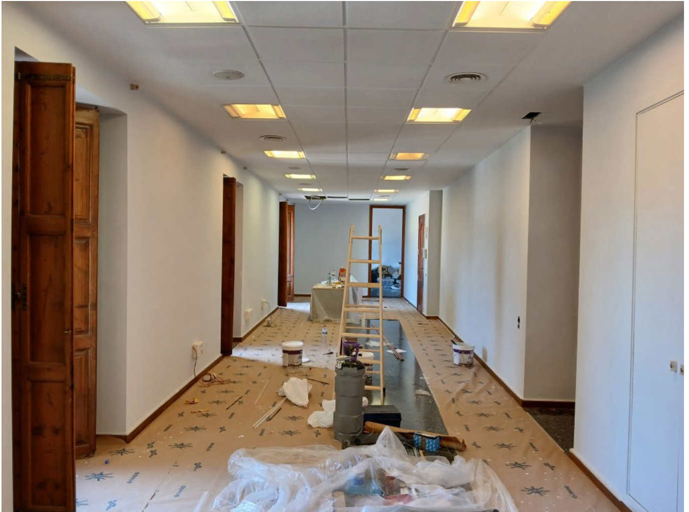
Obres d'habilitació d'espais (2024).
