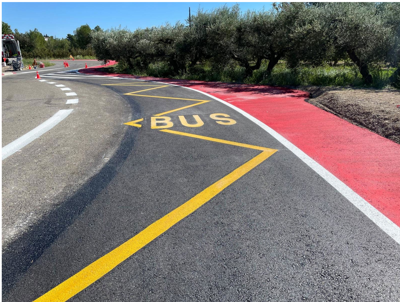
Renovació de la senyalització horitzontal.
