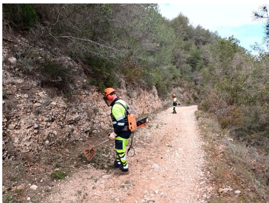
Tasques de desbrossament al camí del Riastre, el Pont d'Armentera
