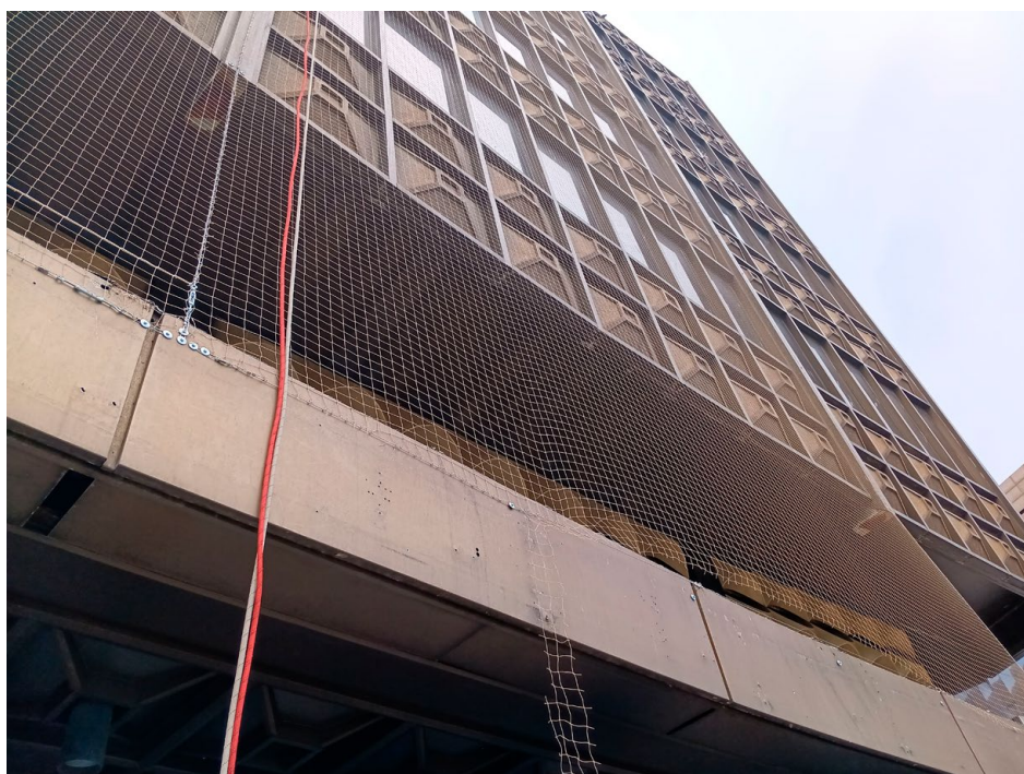
Actuacions de condicionament i manteniment de l'edifici del 2024.
