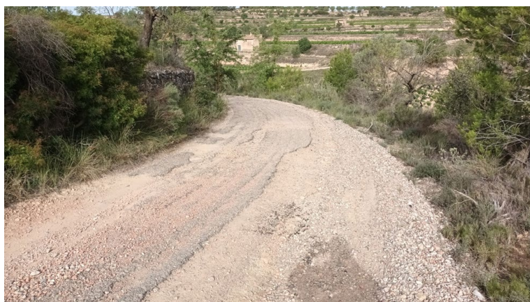
Treballs de pavimentació del camí de les Punes a Gandesa. Estat inicial i final.
