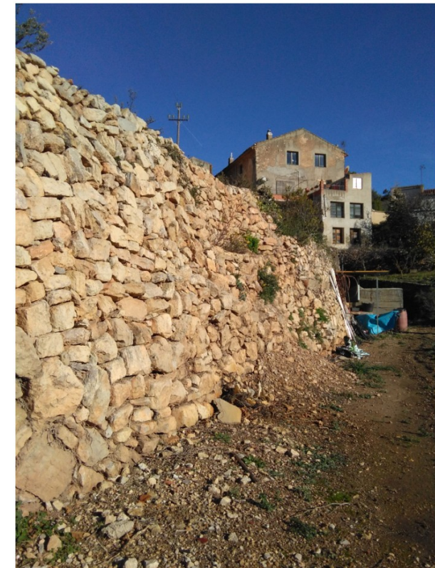
14. Tram inicial. Mur horts costat dret
