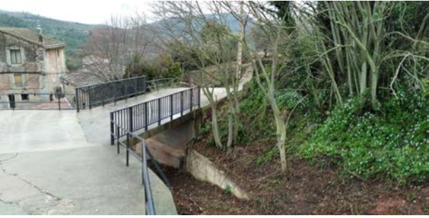
Foto 1: pont existent de creuament del Barranc del Puig de la Font aproximadament al futur PK 0+280 d’ambdues alternatives.
