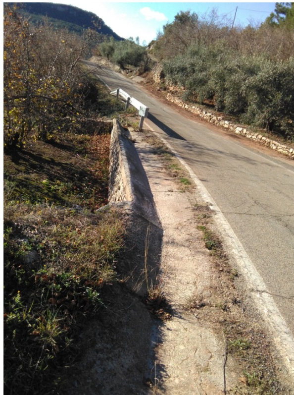
06. Tram inicial. Cuneta i barrera.
