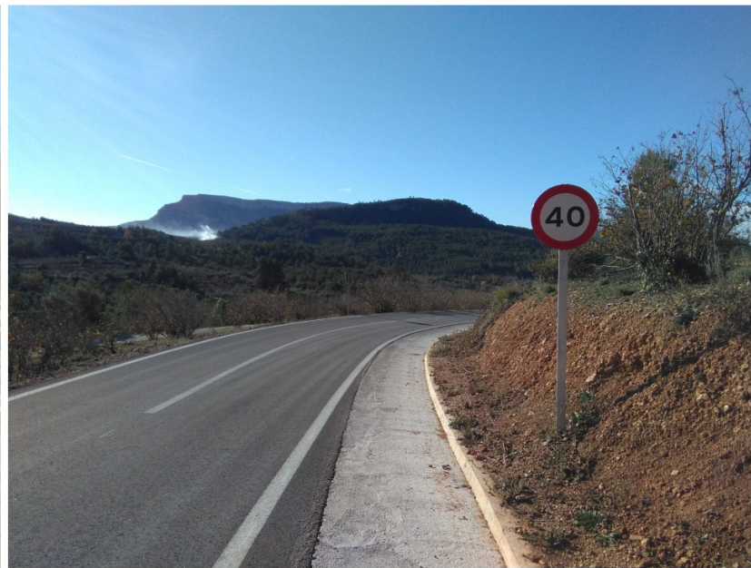
02. PK 5+150 Inici tram executat
