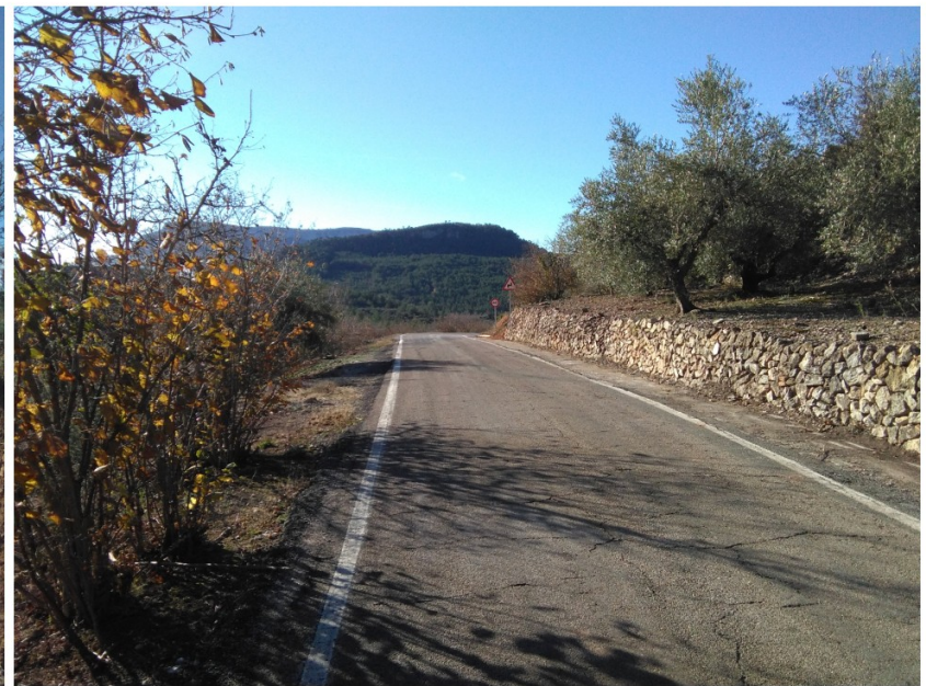
03. Tram inicial i mur de pedra seca
