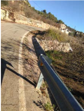
Foto 6: vista de cunetes formigonades existents a la TV-3223.
