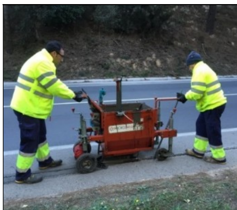
exemple de treballs de rebliment de la rasa.
