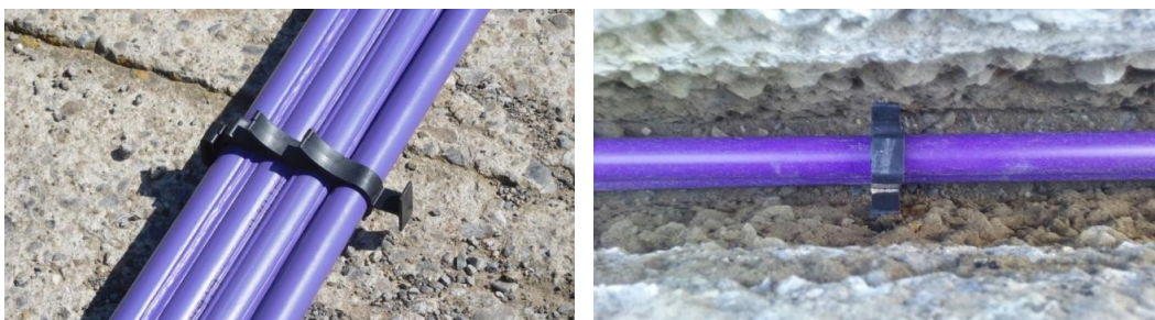
Separador de plàstic per homogeneïtzar la distribució del morter.
