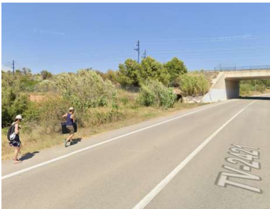
Figura 13. Vista estat actual futur itinerari segur
